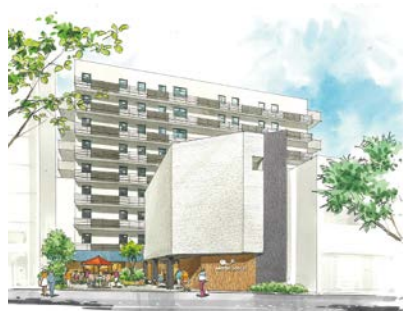
ホテルソピアル 大阪 ドーム前
